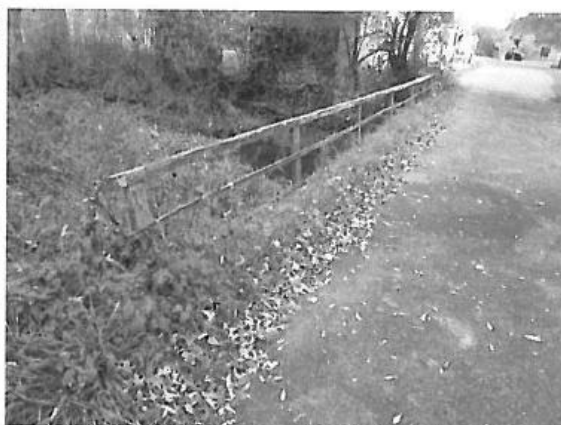
mosty Pamětník po10 015 levá krajnice a vyhnuté zábradlí
