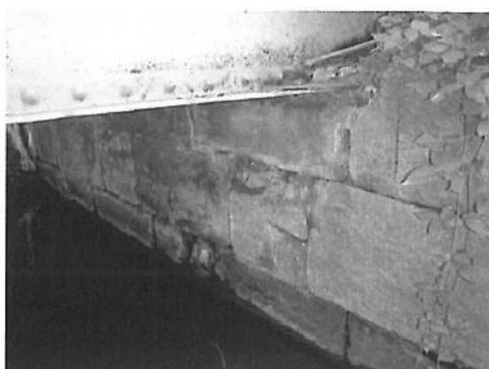
Vyloužené spáry mezi kvádry v opěře
