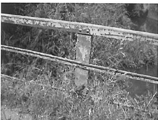
Zrezivělé zábradlí
