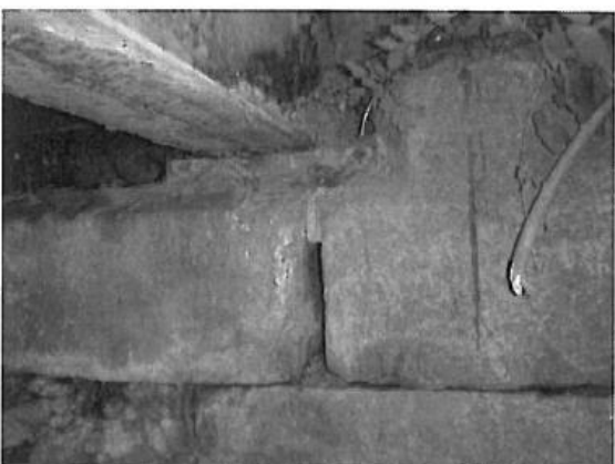
Zanesené a nefunkční ložisko
