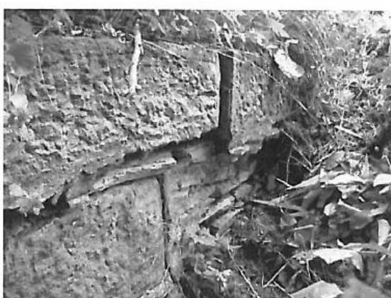
Uvolněné kvádry křídla opěry
